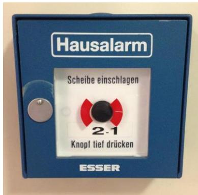
Die dafür erforderlichen Druckknopfmelder (Foto 3) befinden sich in der Regel im Bereich der Treppenaufgänge und/oder der Gebäudeausgänge. Die dünne Schutzscheibe lässt sich gefahrlos mit dem Ellenbogen oder einem Gegenstand (Schuh, Schulschlüssel usw.) einschlagen. Druckknopfmelder mit blauem Gehäuse geben Hausalarm aus, Feuerwehr und Polizei erhalten hier allerdings keine Kenntnis.
